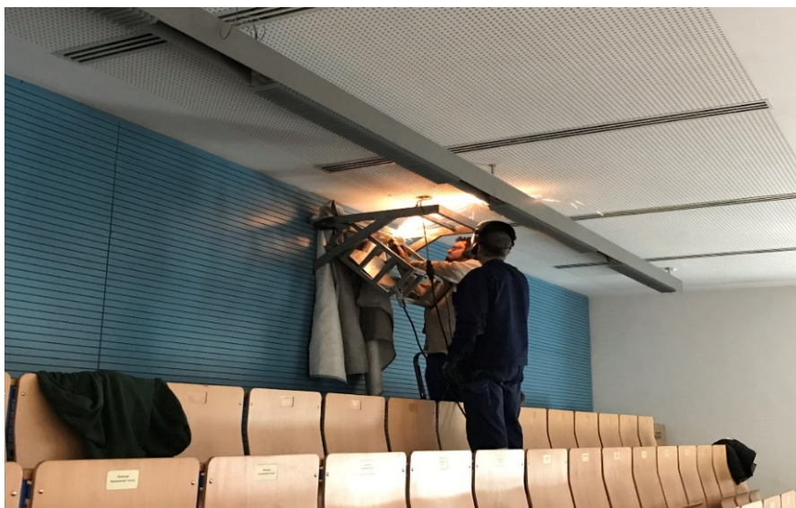
Abbildung 5: Schweißarbeiten durch den Technischen Betrieb (Foto: RZ)
